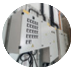
Fabrication de panneaux et tableaux de contrôle
