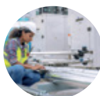
Panneaux de commande CVC
