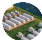
Stockage d'énergie sur batterie
